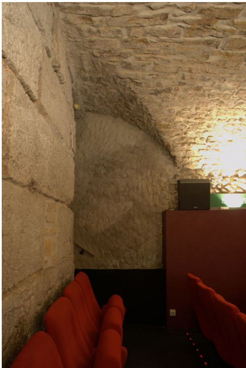
Sous-sol (actuelle salle 1 du cinéma), détail du mur en galets
