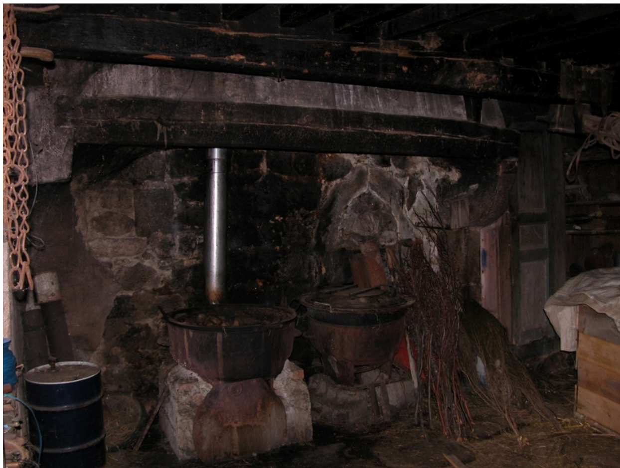
Vue intérieure de la cuisine du premier logis : cheminée.
