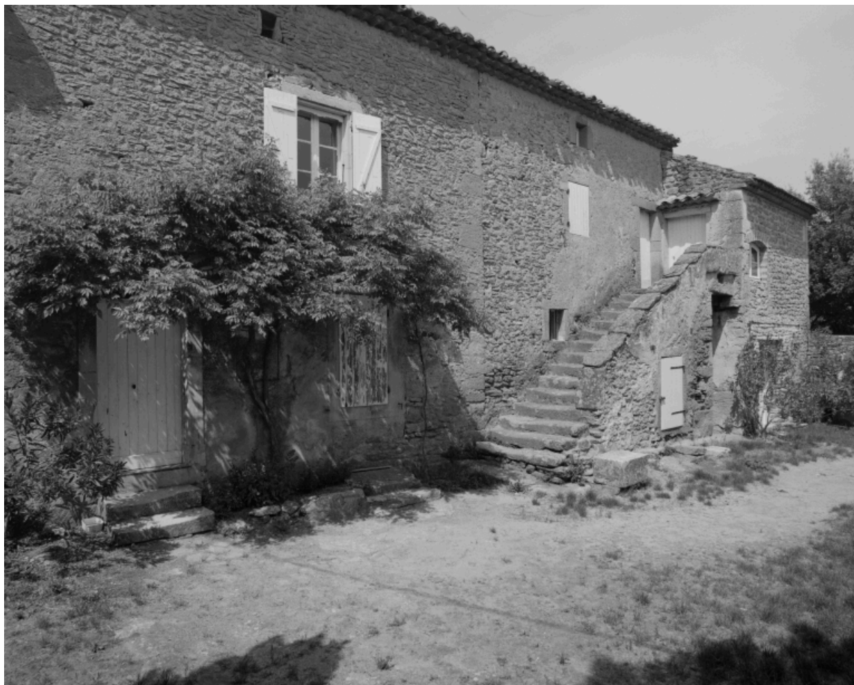
Le corps de logis, vue prise du sud.
