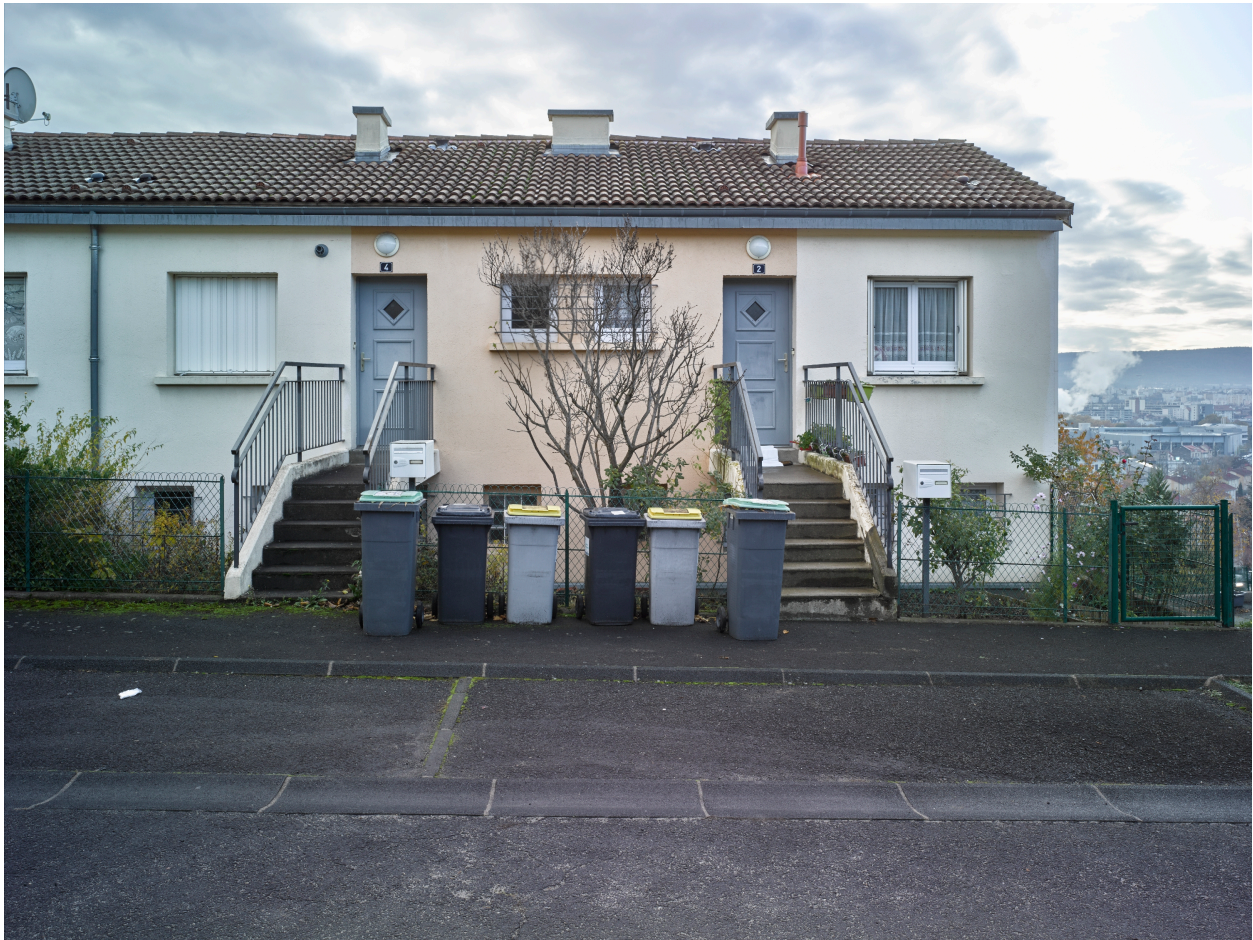
Maisons accolées en bande sur terrain pentu, avec passerelles du côté haut, années 1956-1960 (cité de Saint-Vincent).
