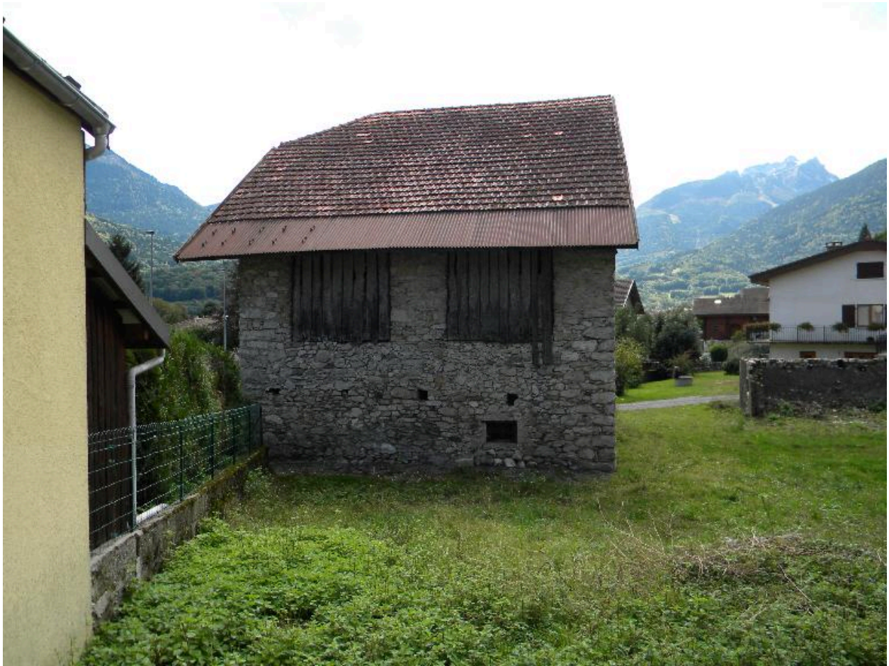
Vue de la façade nord.
