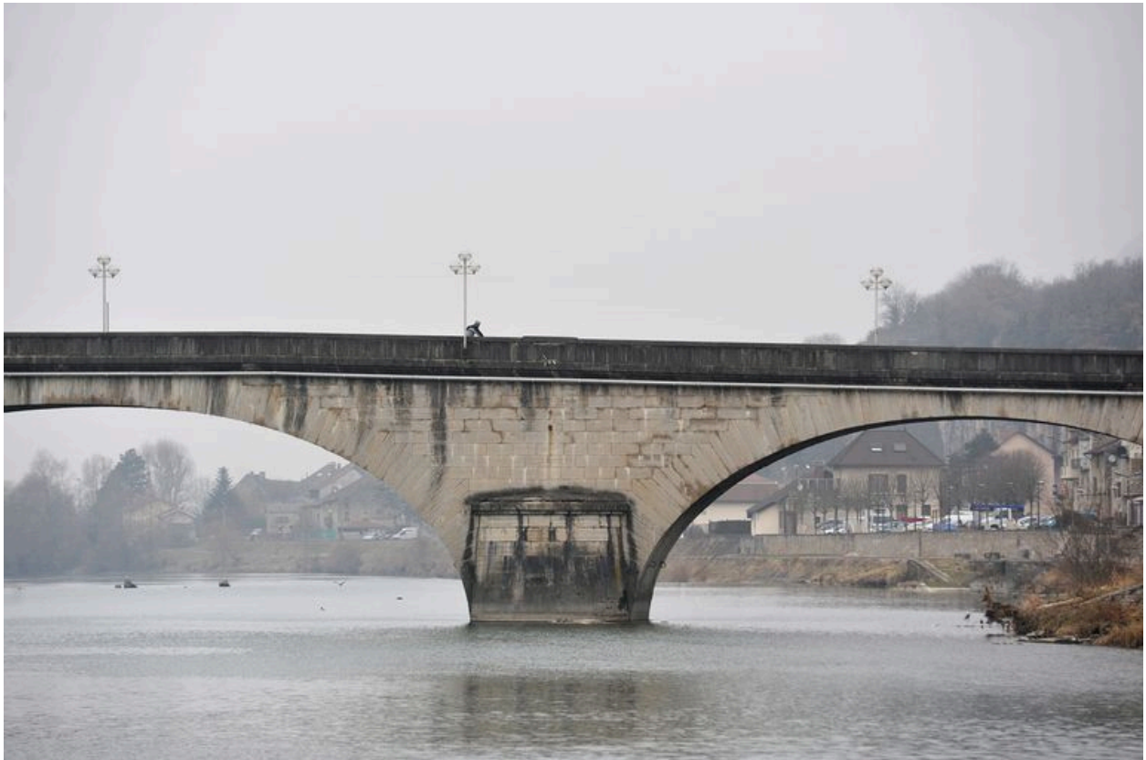
Vue partielle, face amont (depuis la rive gauche)
