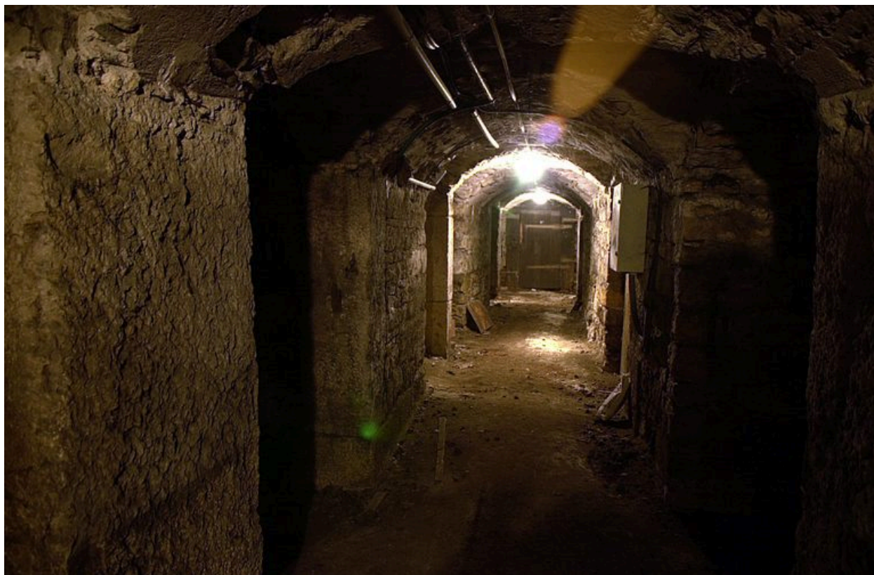
Caves sous l'immeuble 3 rue de Savoie : l'allée centrale
