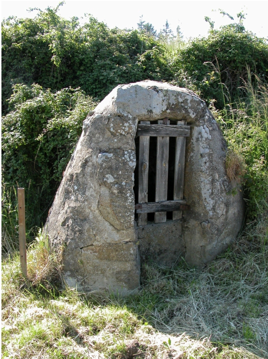
Vue du puits (parcelle 1986 D 1088).
