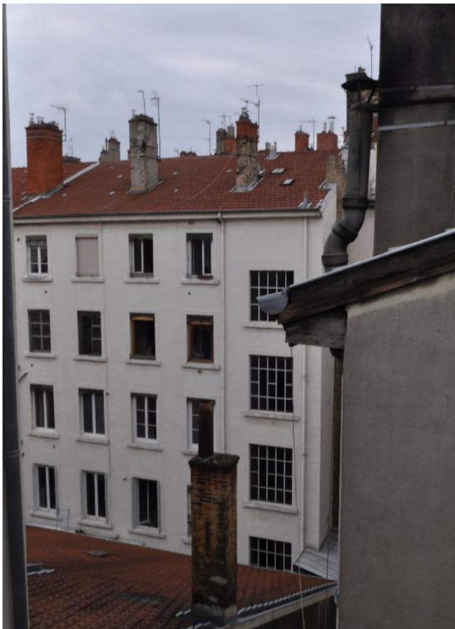
Vue générale de l'élévation sur cour
