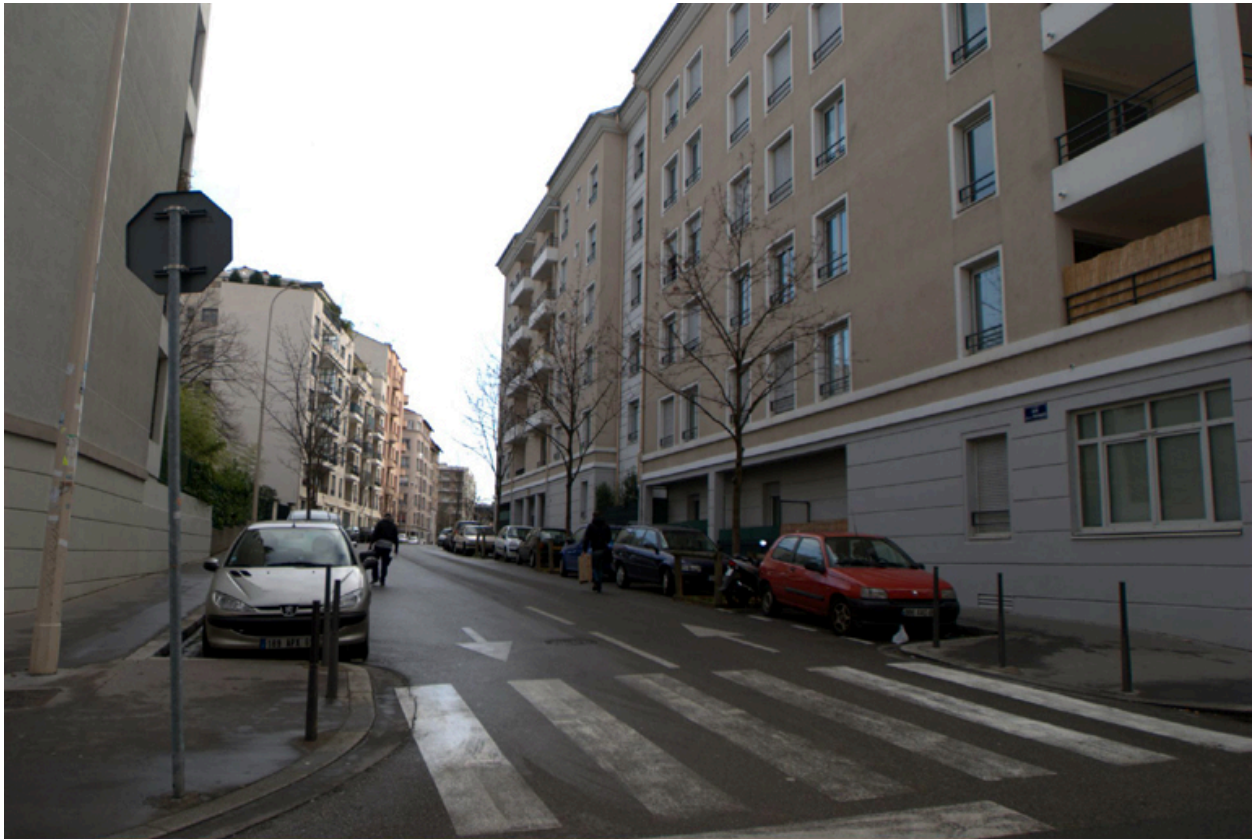
Vue de la partie nouvellement percée de la rue Jules-Brunard, depuis la rue Victorien-Sardou (depuis l'ouest)
