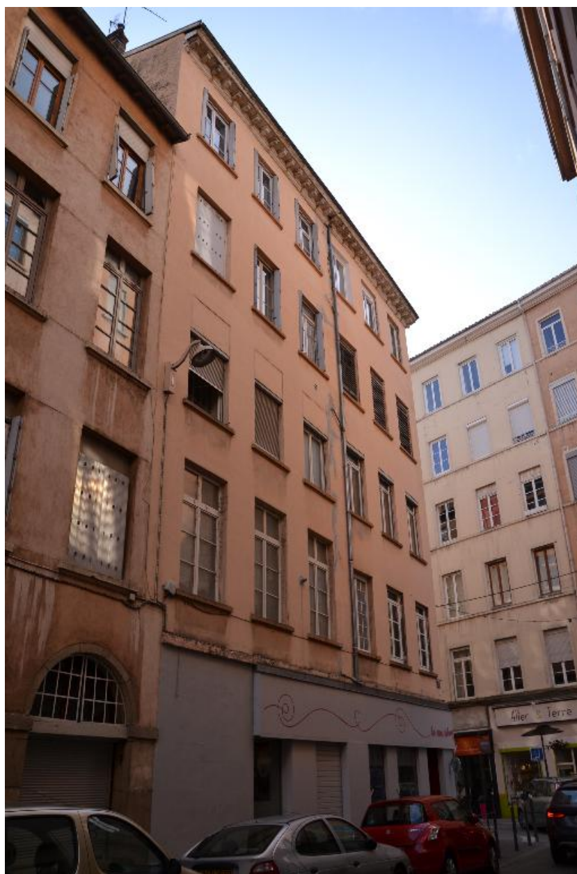
Vue d'ensemble façade ouest
