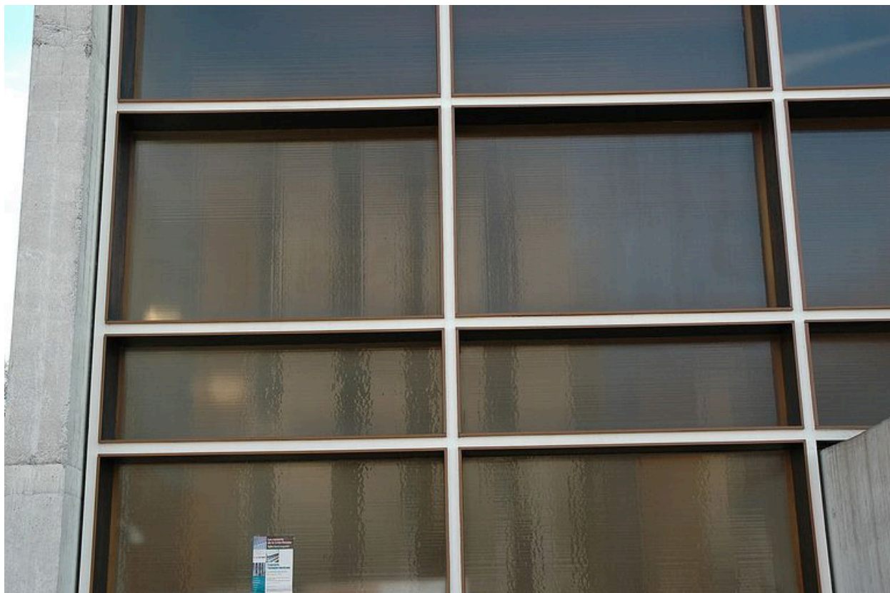
Détail de la façade principale
