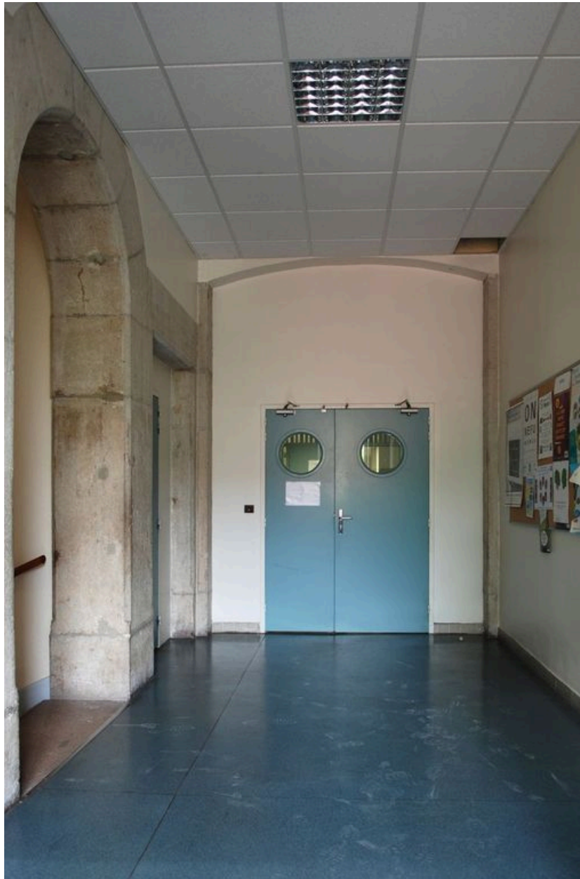
Bâtiment des services généraux, palier de l'escalier nord, premier étage
