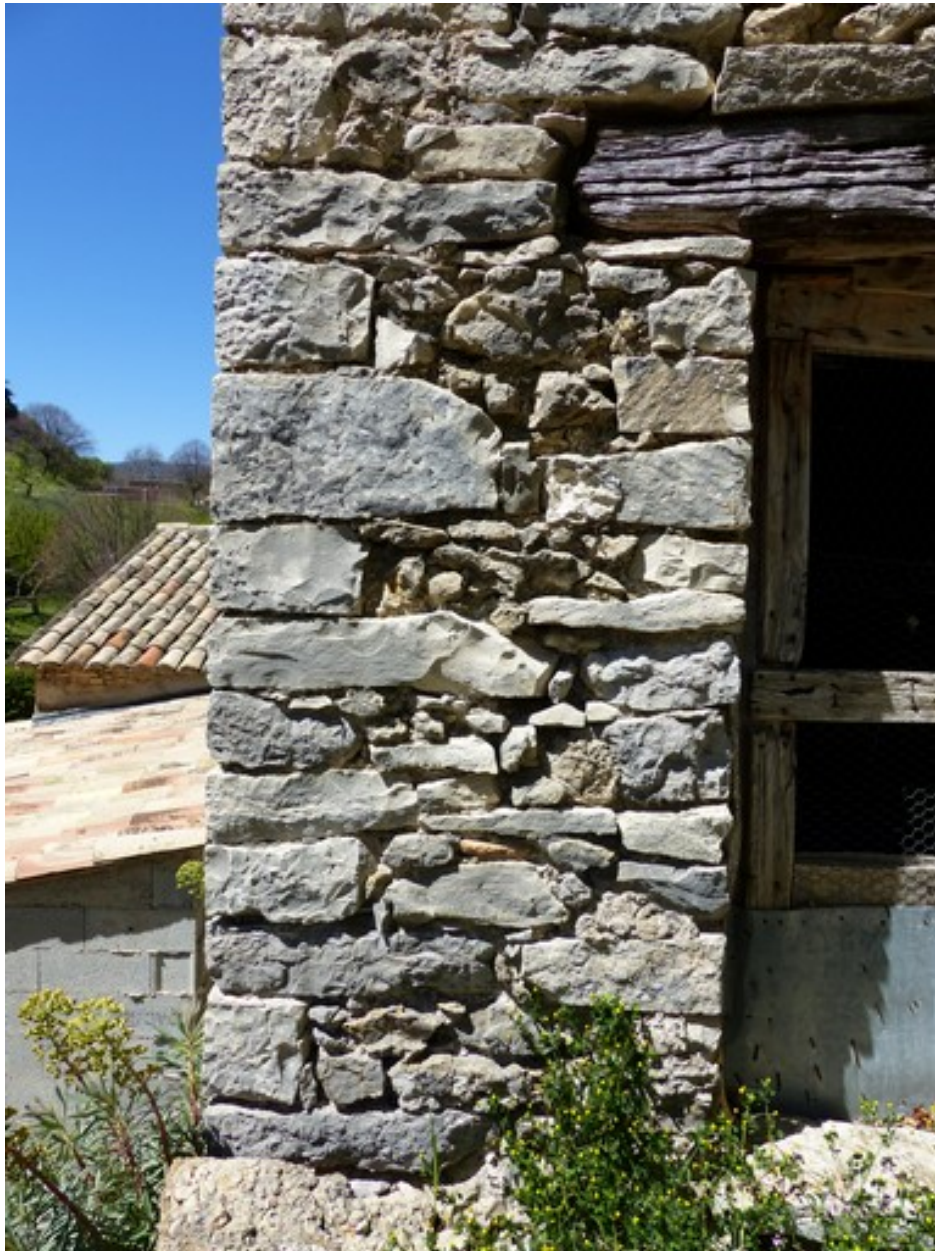
Chaîne d'angle sud-est et piédroit de la porte.
