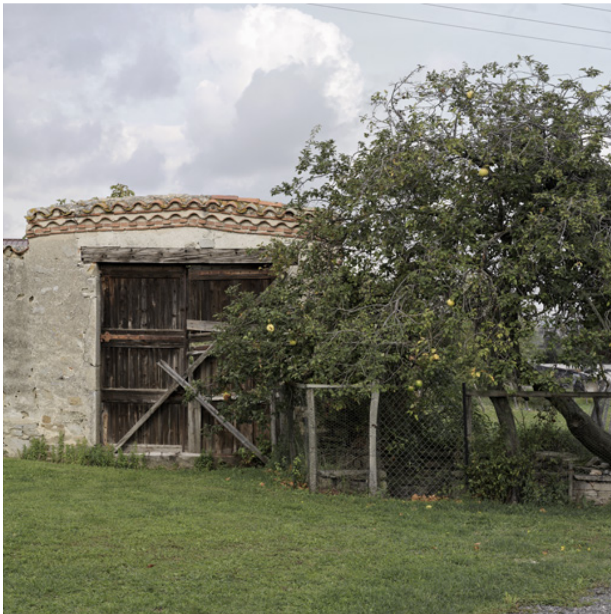
Vue du portail nord, depuis le sud.
