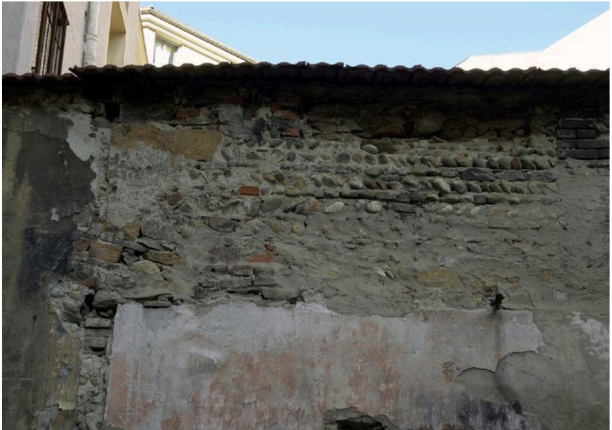
Cour, mur de clôture (mur ouest), détail
