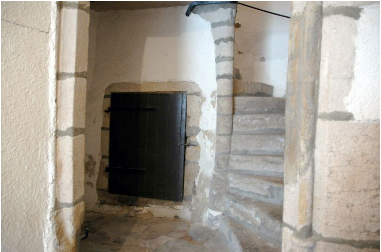
Puits dans le mur-noyau de l'escalier en vis.
