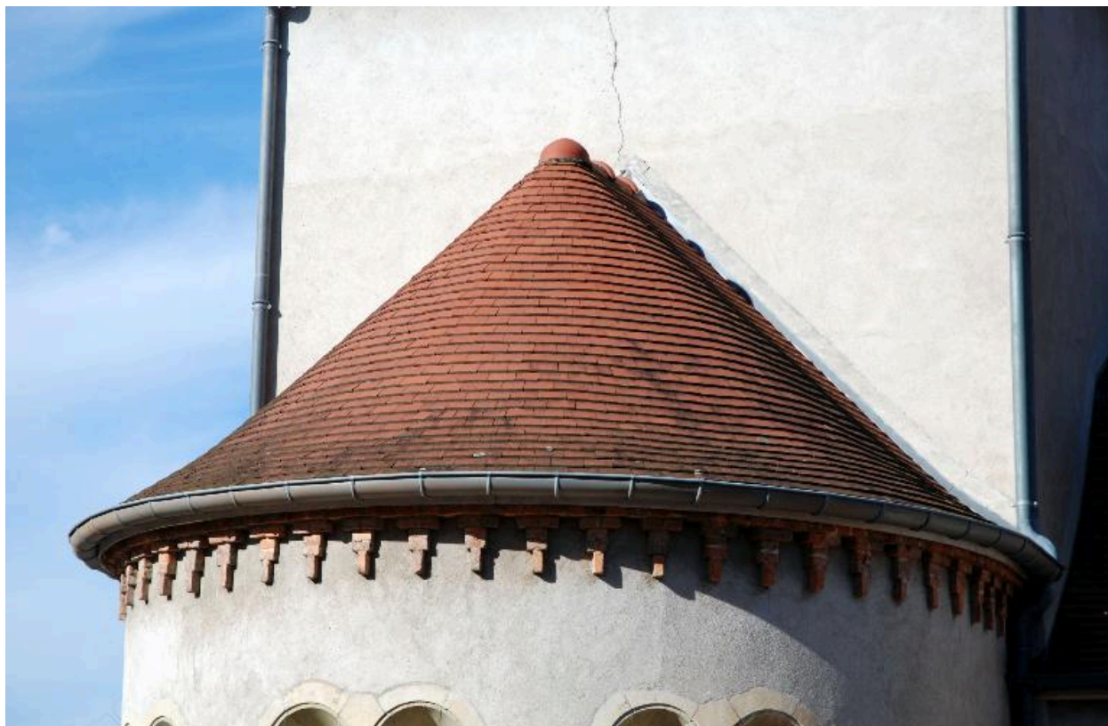
Abside de l'oratoire : détail de la toiture
