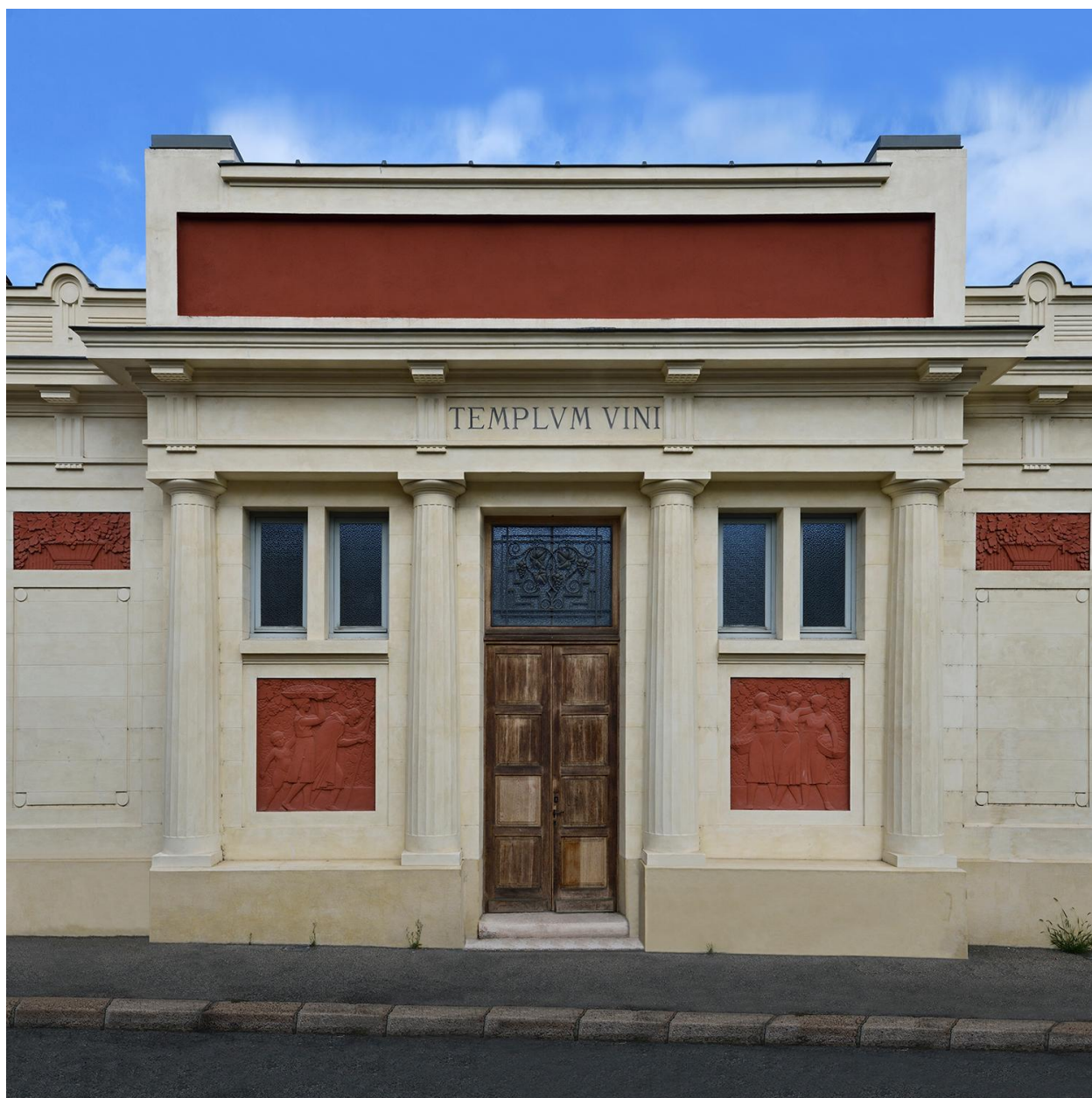
Corps de bâtiment central
