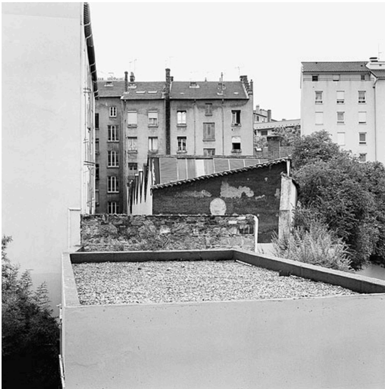
Vue générale nord des ateliers (sheds)
