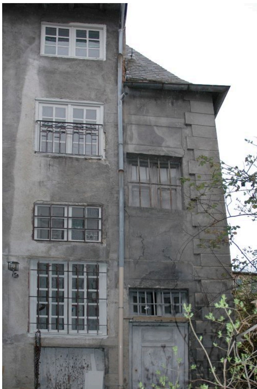
Vue partielle de l'escalier demi-hors-oeuvre sur cour.
