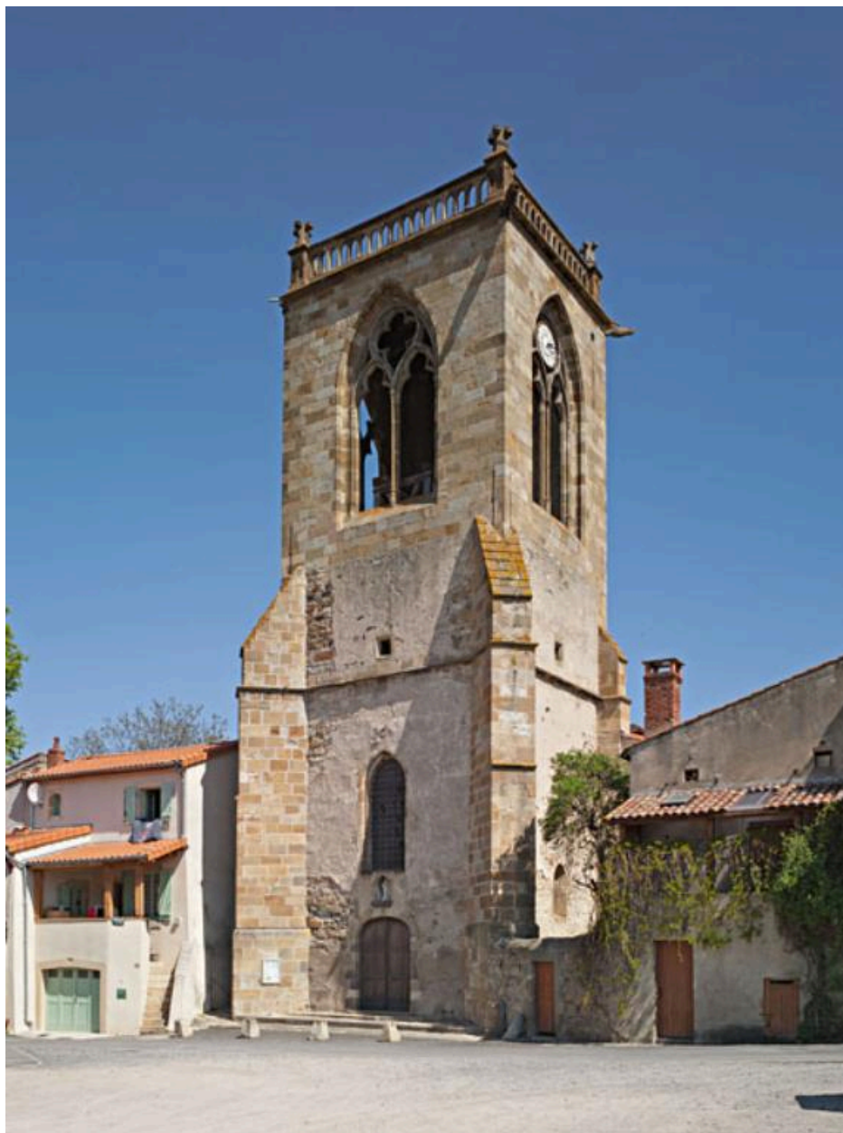
Vue générale de la façade occidentale.
