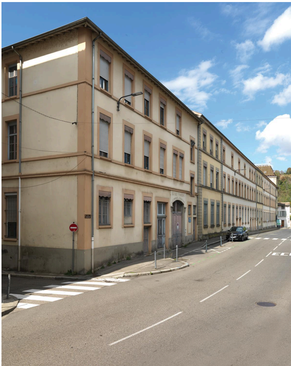
Elévation postérieure, depuis le sud
