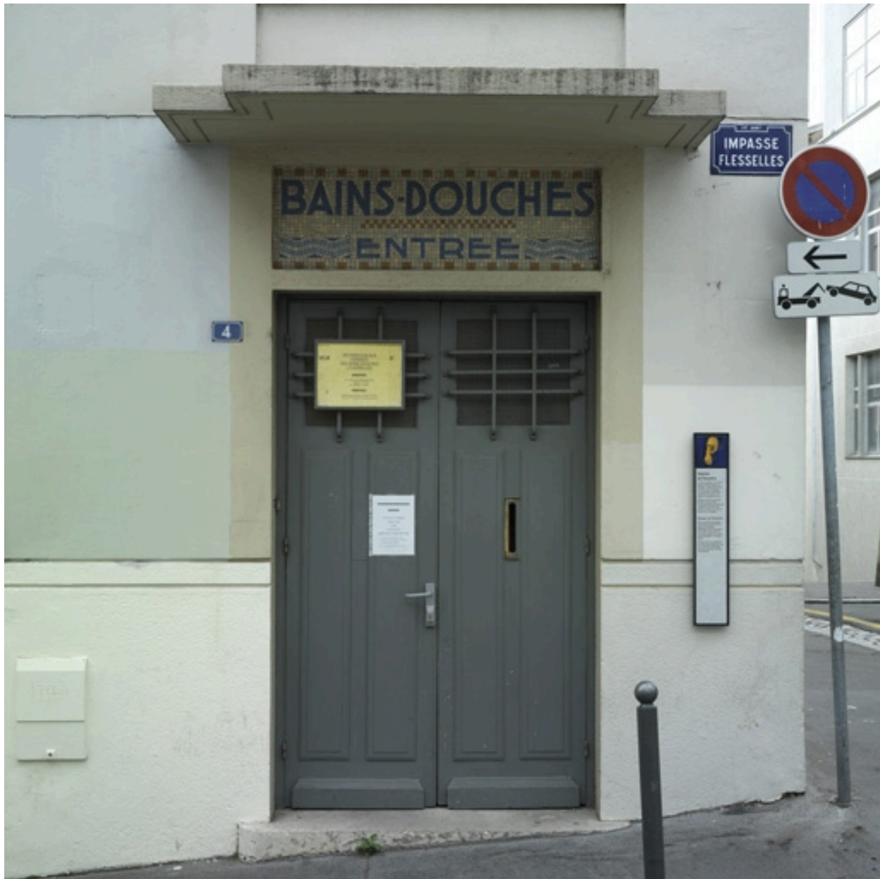
Porte d'entrée : enseigne en mosaïque des bains-douches
