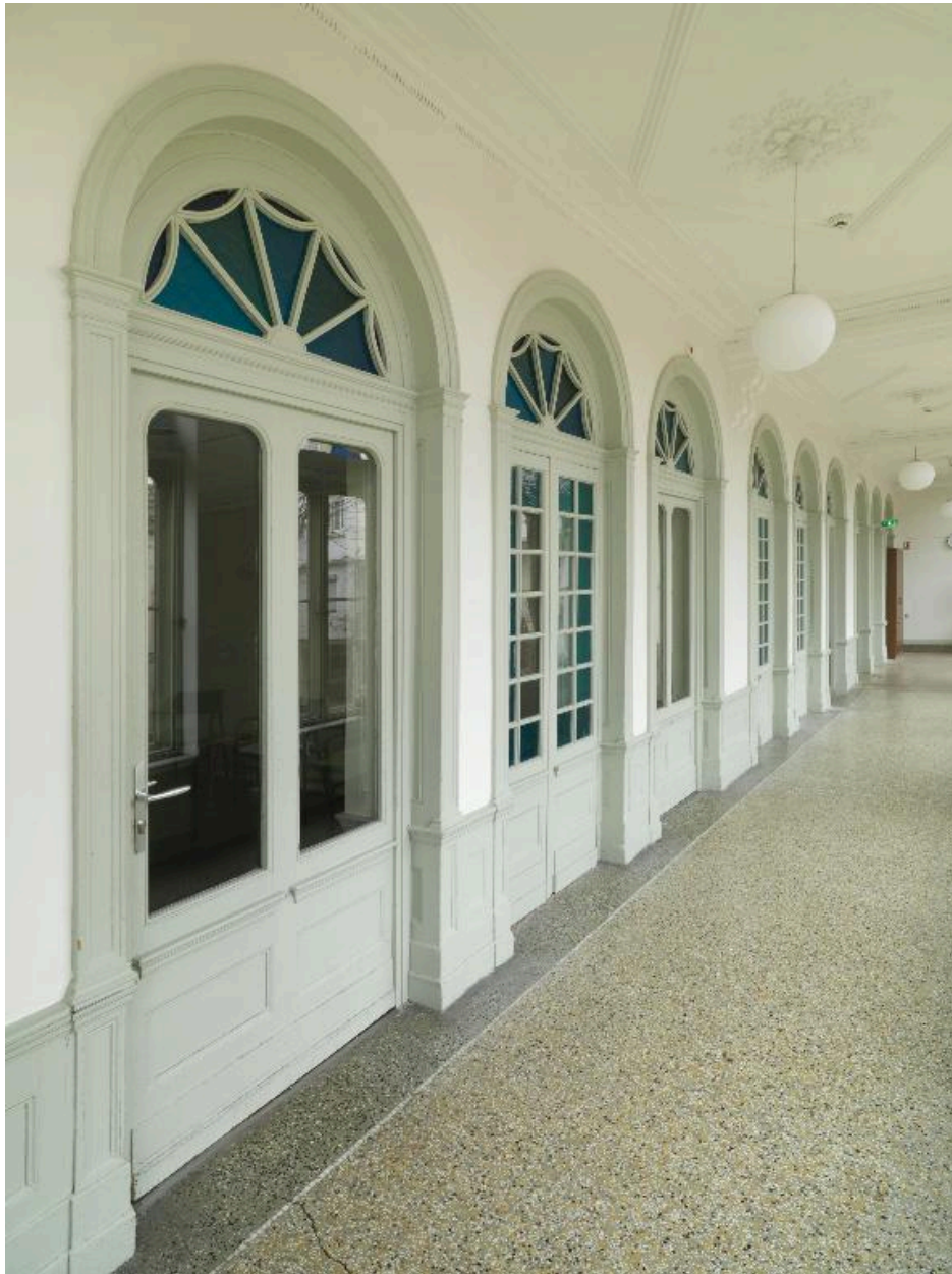
Vue intérieure : les portes ouvrant sur le couloir du rez-de-chaussée
