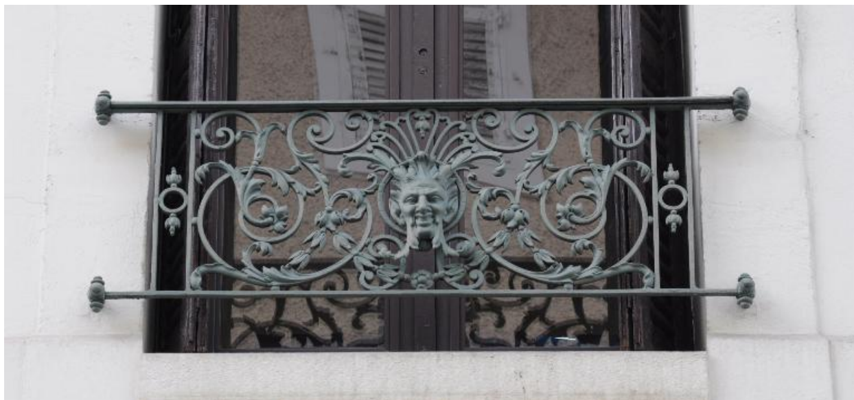
Détail d'un garde-corps
