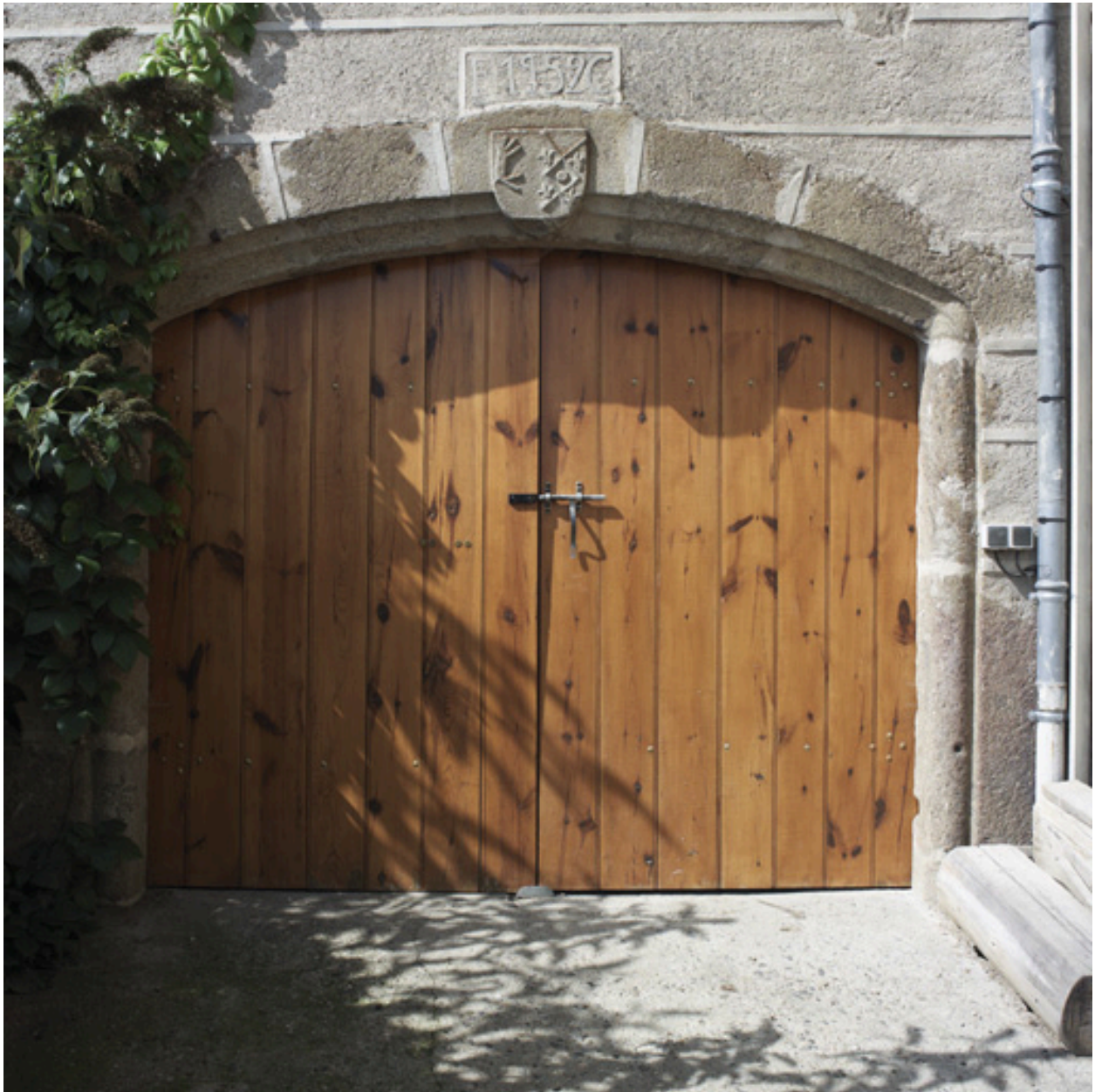
Ferme AI 64 du château, vue d'ensemble du portail sur cour de l'étable.
