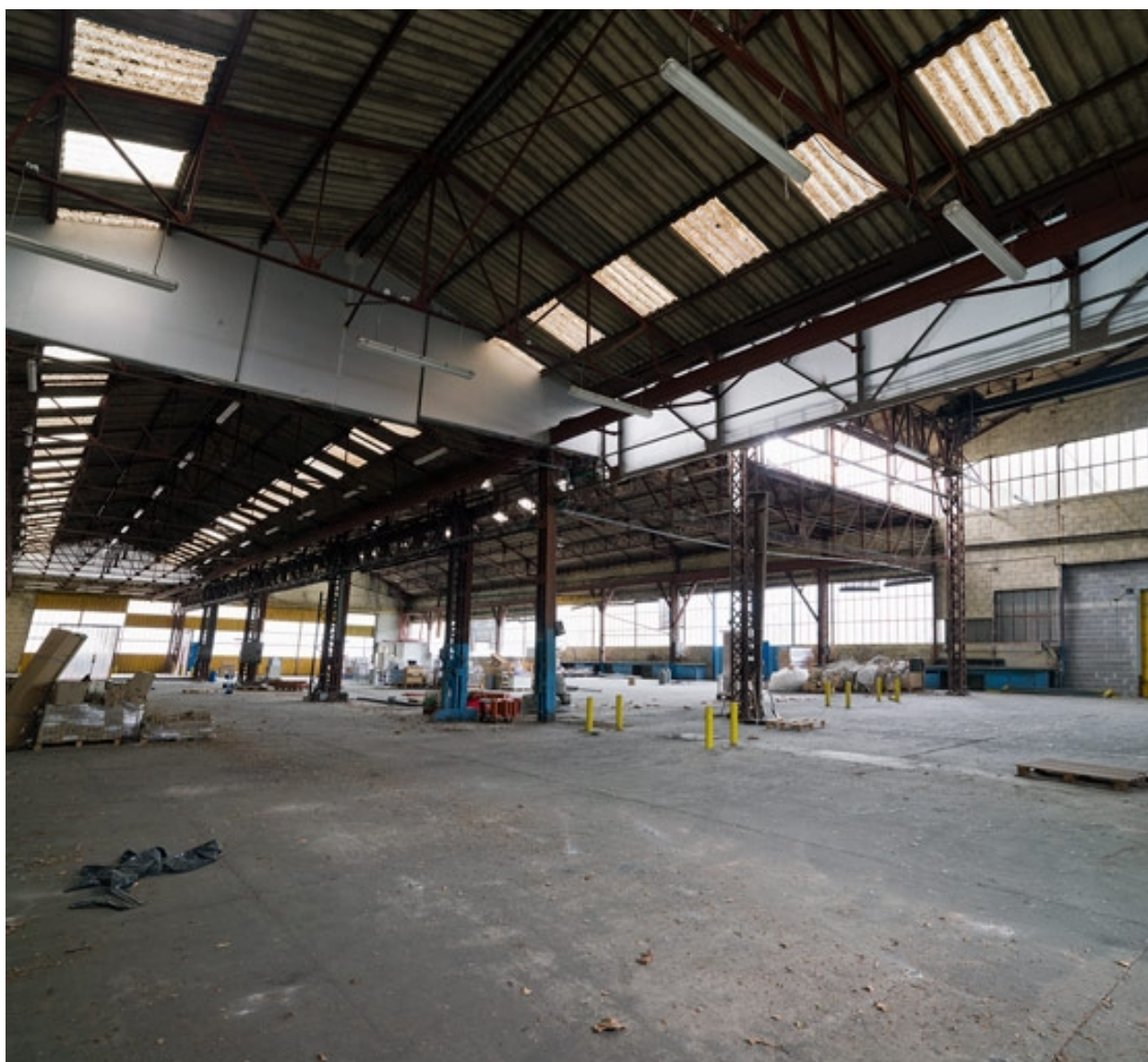
Vue d'ensemble intérieure des ateliers
