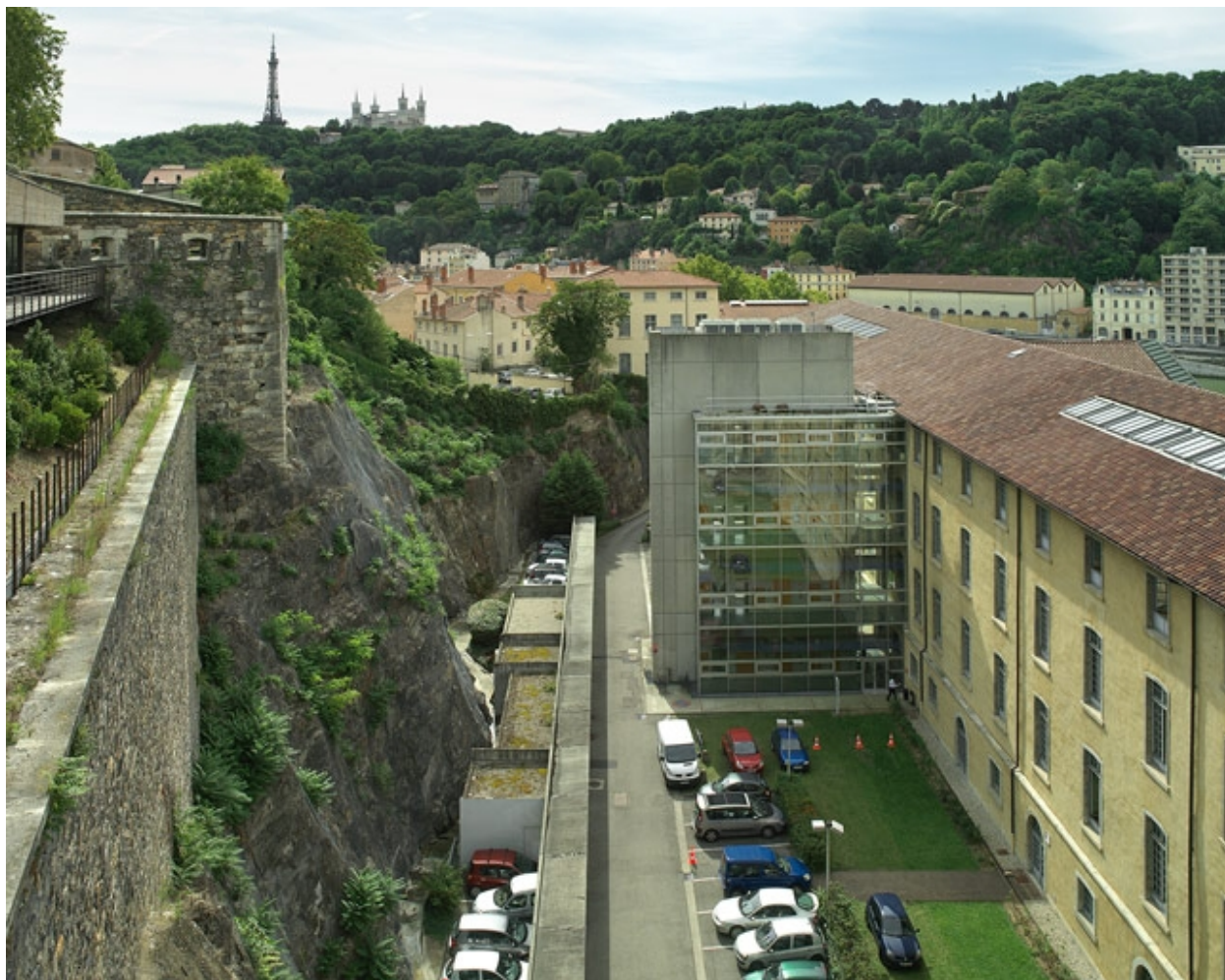
Vue d'ensemble est
