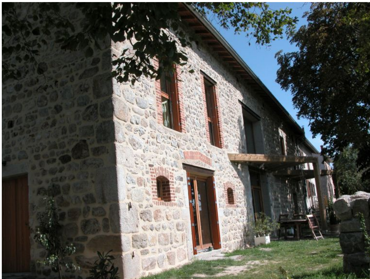
Vue d'ensemble de la façade principale.
