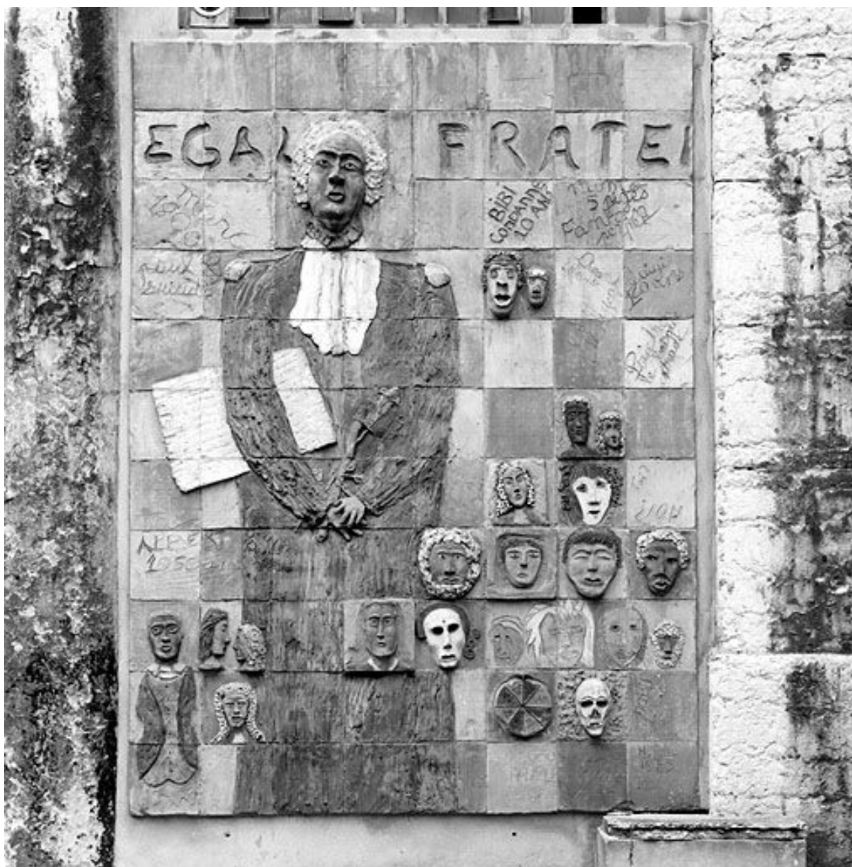
Elévation nord de la cour d'honneur, panneau situé à l'est (5)
