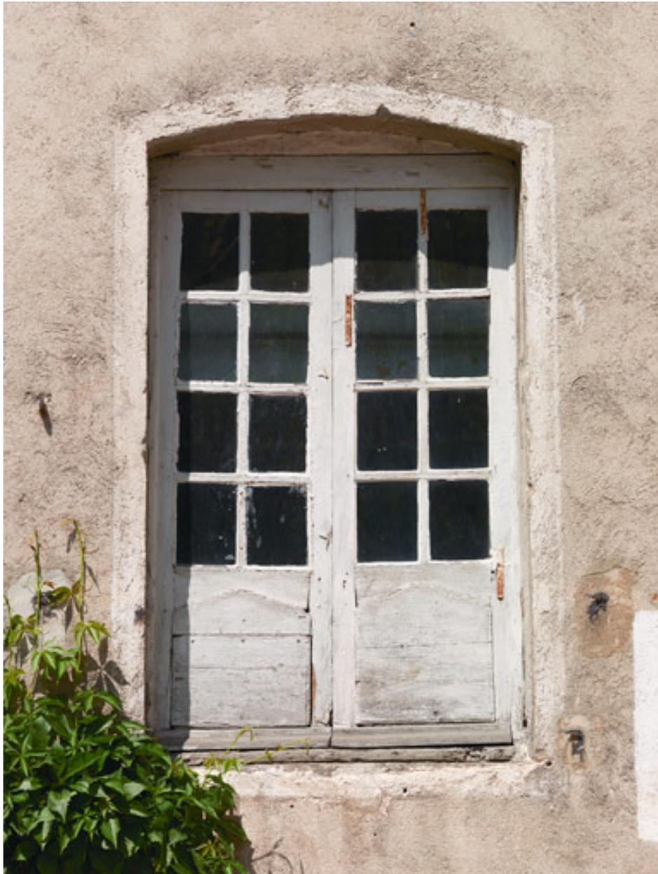
Bâtiment B : fenêtre en arc segmentaire et menuiserie du 18e siècle de l'étage de soubassement, élévation sur cour.
