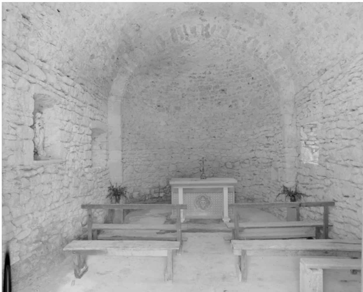
Vue de l'intérieur, prise depuis l'entrée.
