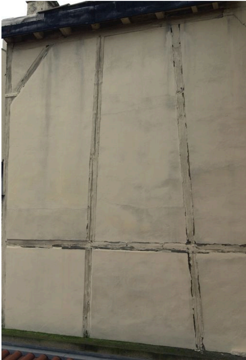
Mur en pans de bois mitoyen avec AM 30
