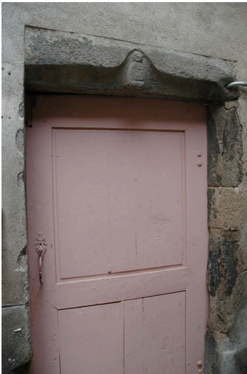
Porte piétonne sur cour.
