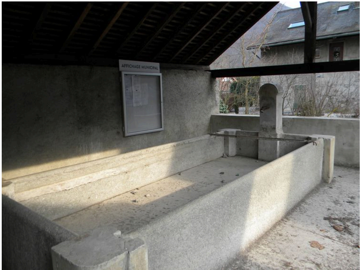
Vue du bassin sous la charpente.
