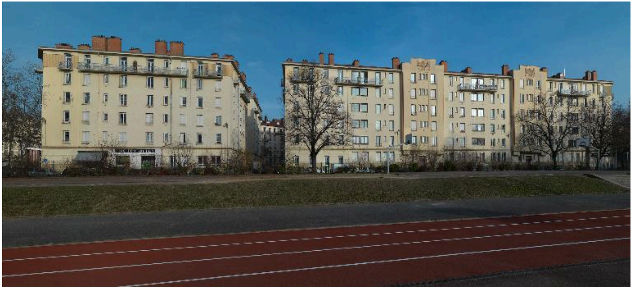
Vue d'ensemble des façades donnant sur la rue Marie-Anne-Leroudier depuis le stade Roger-Duplat
