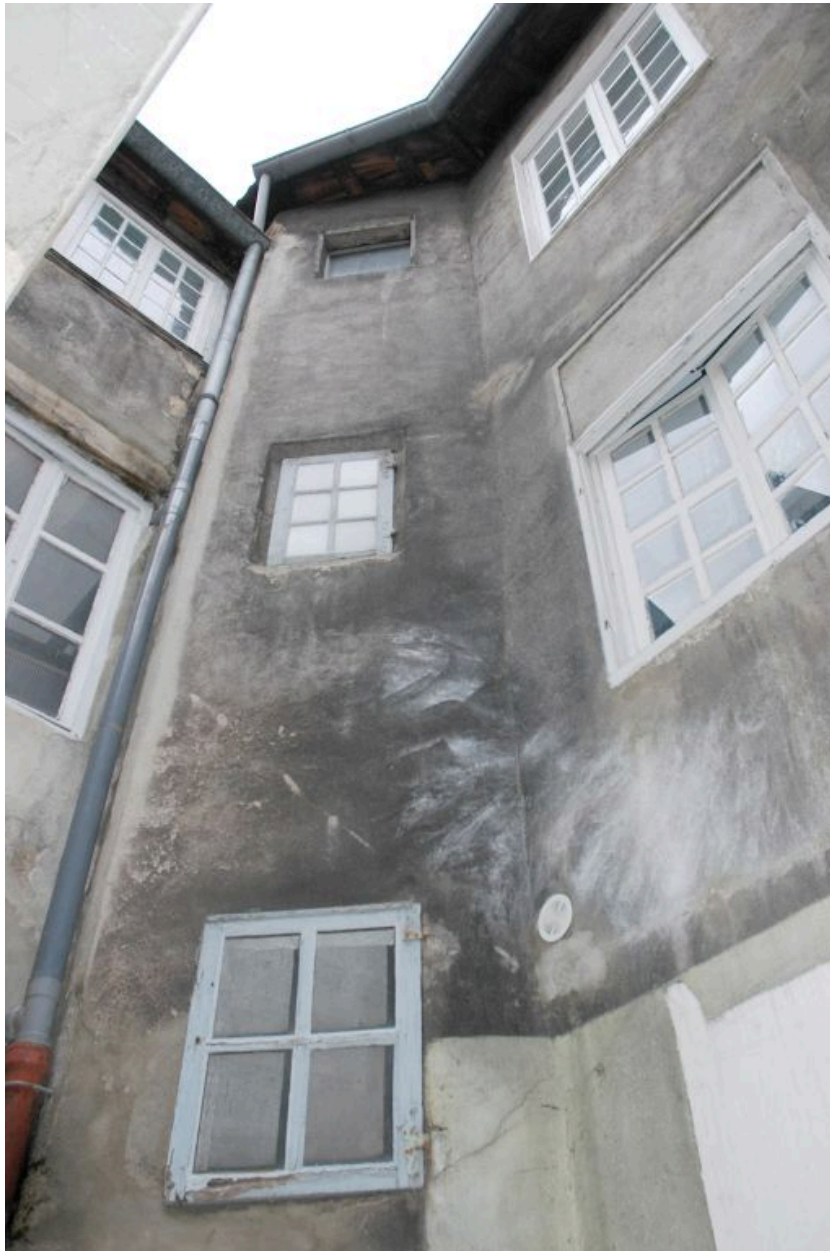
Cage de l'escalier en vis demi-hors-oeuvre situé dans la cour.
