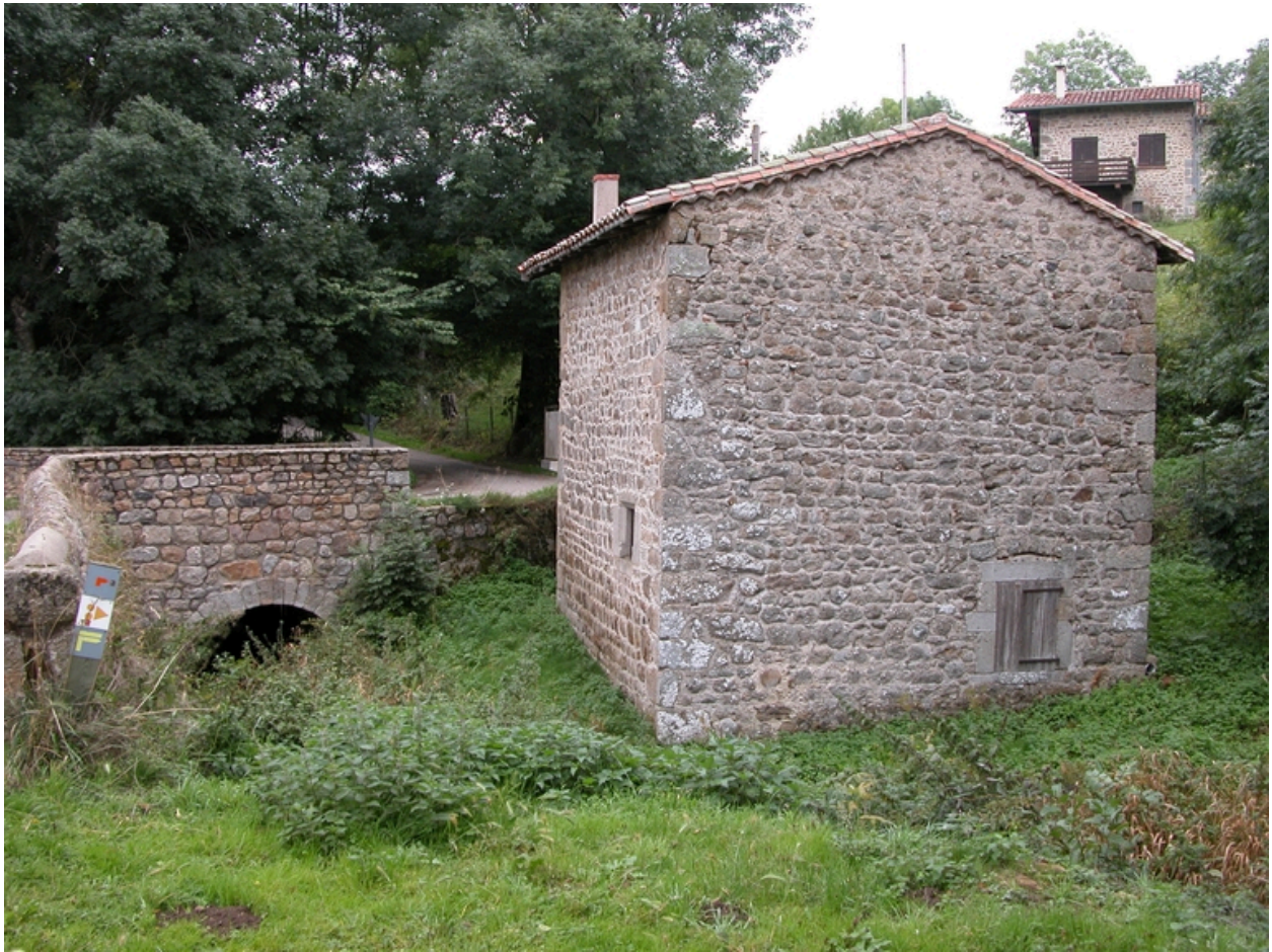
Vue d'ensemble du moulin, depuis le nord-ouest.
