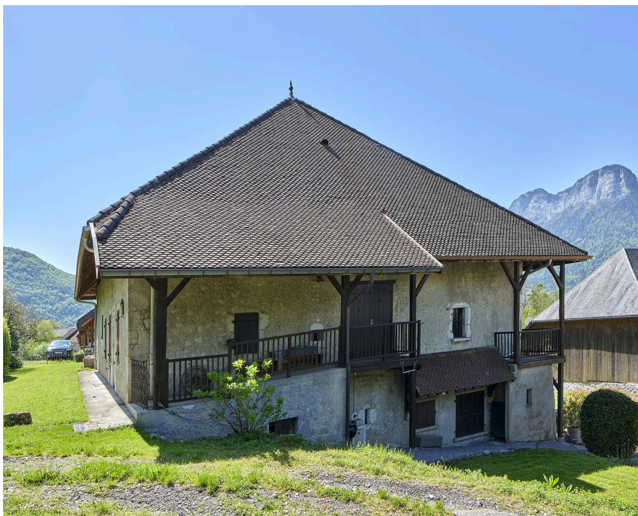
Vue d'une façade.
