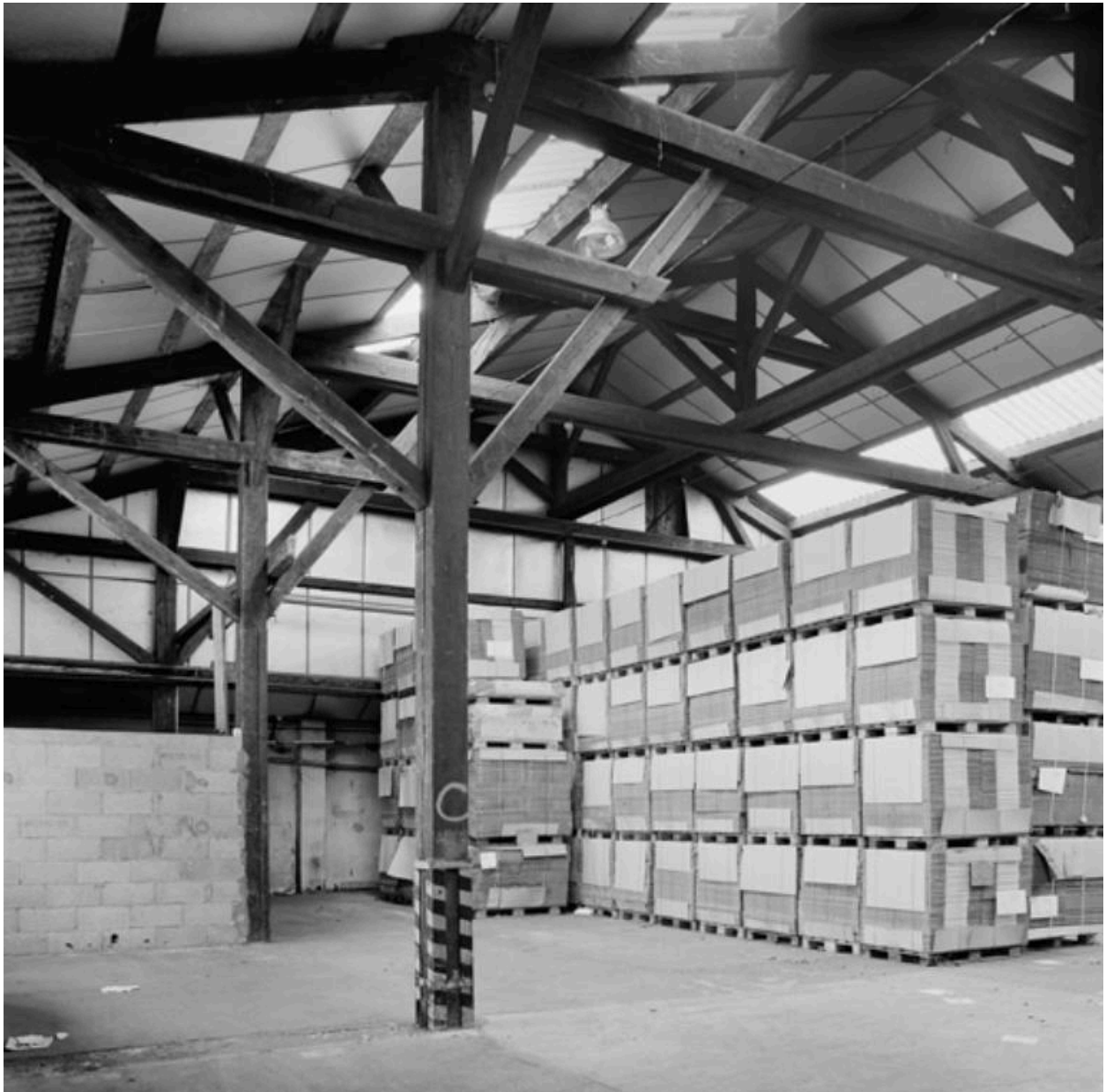
Stockage des marchandises, charpente bois intéressante.
