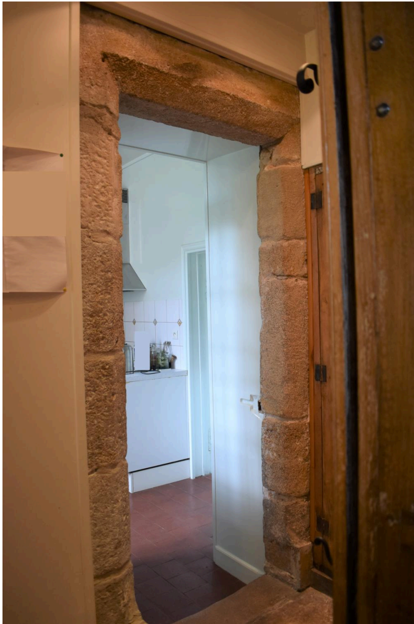
Porte à encadrement de pierre de taille et linteau chanfreiné, rez-de-chaussée.
