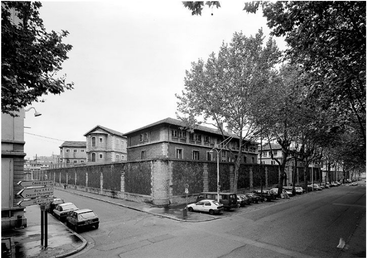
Vue générale depuis l'angle formé par le cours Suchet et la rue Smith
