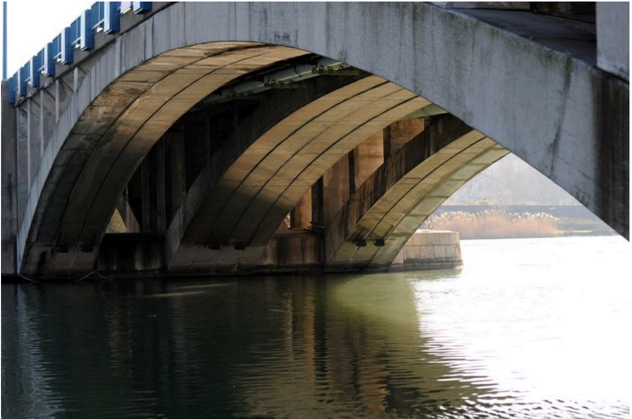
Vue partielle, de dessous, travée droite, face amont (depuis la rive droite)
