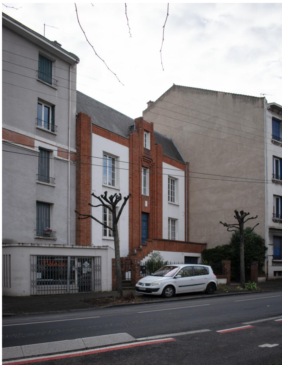
Pignon d'alignement sur le boulevard Jean-Jaurès
