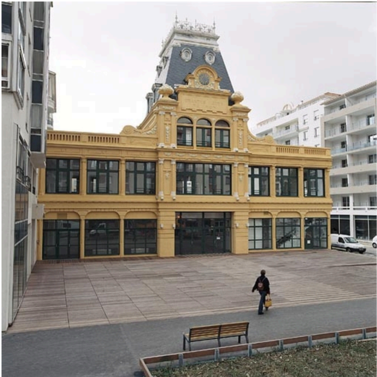
Vue générale nord
