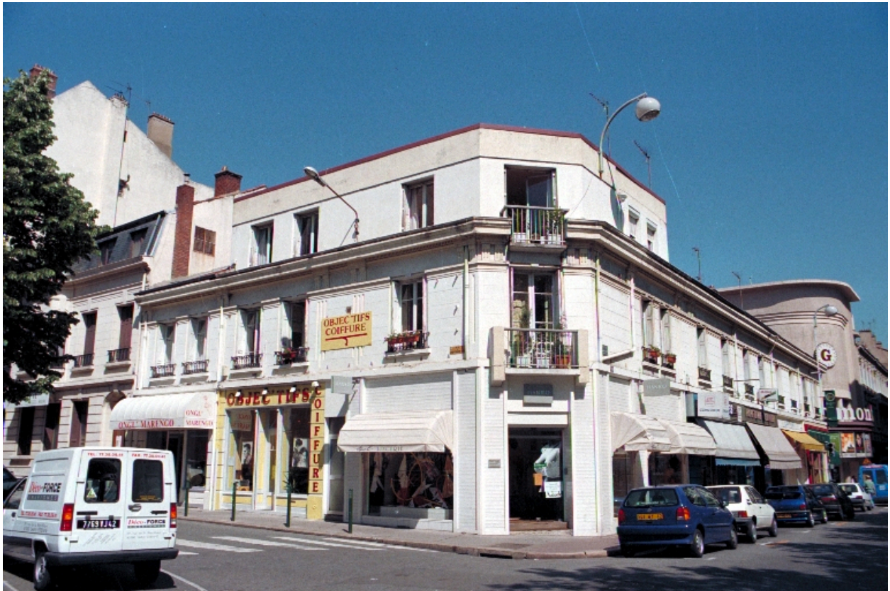
Vue d'ensemble. Etat en 1996
