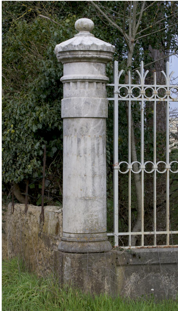
Portail sud, détail d'un pilier maçonné
