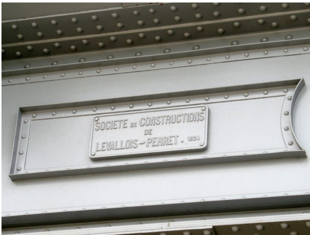
Travée de rive gauche, face amont, vue de détail : marque du constructeur
