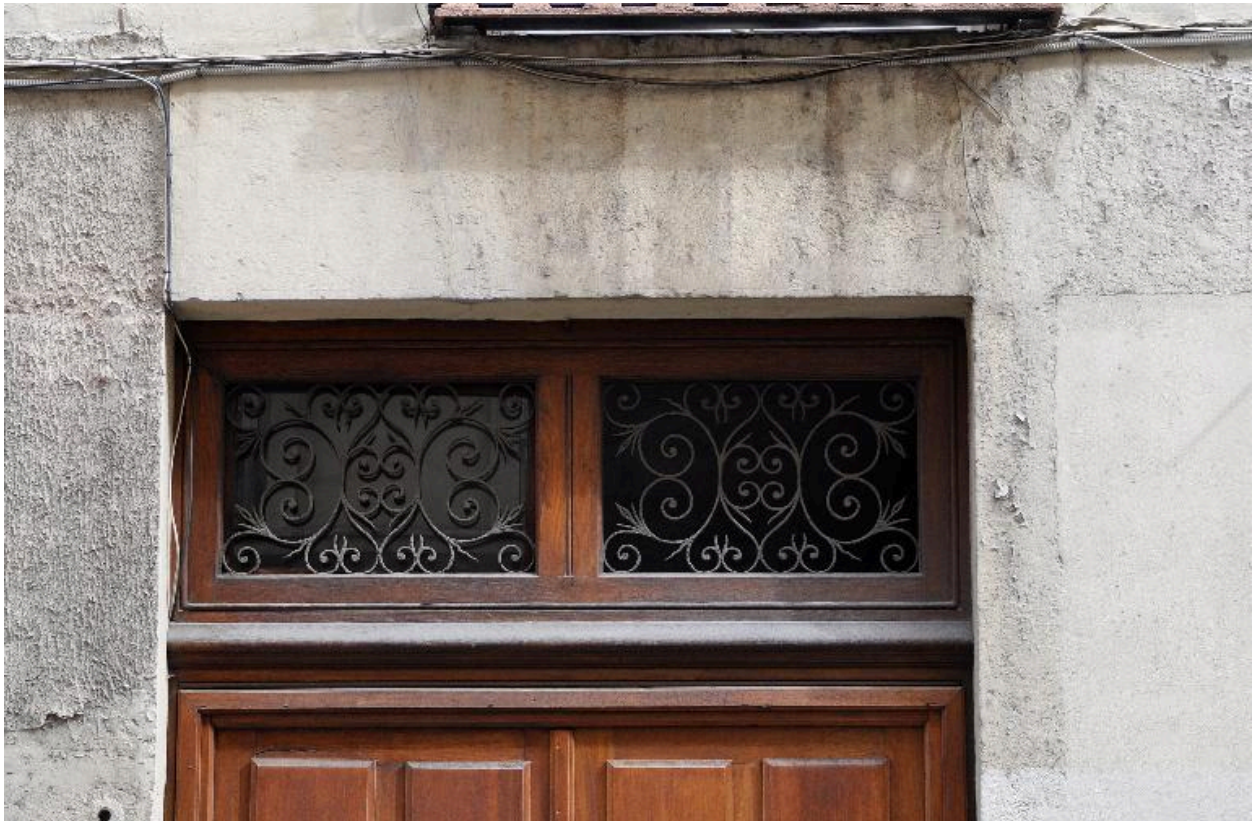
Détail de l'imposte en ferronnerie
